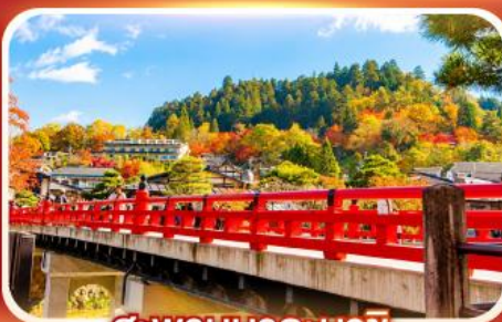
สะพานนากะบาชิ
